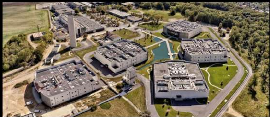
Datacenter de DATA4, à Paris-Saclay 100 MW
